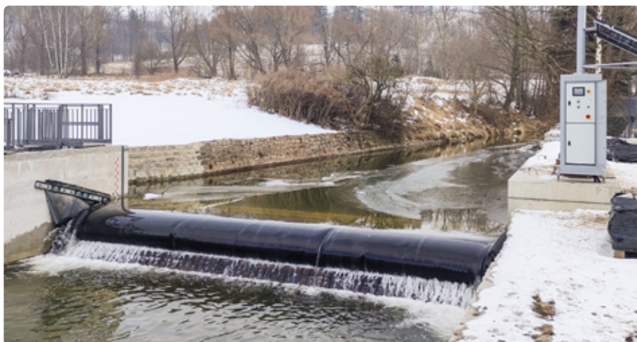
Fig. 4. Autonomous weir (Kamienna Góra, the Zadrna River, 2022)
